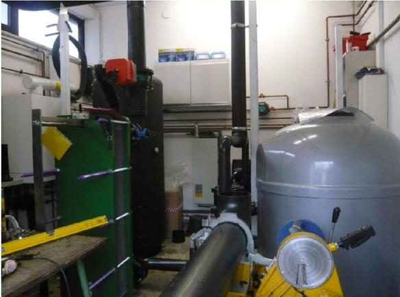
Der hintere schwarze Kessel mit über 1.000l Fassungsvermögen ist der Speicher für die Duschwassererwärmung
